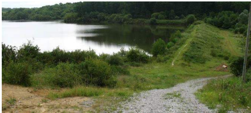
Barrage de la retenue d'eau de Bédorède
